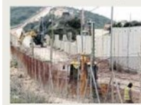
Il muro in costruzione al confine tra Libano e Israele
