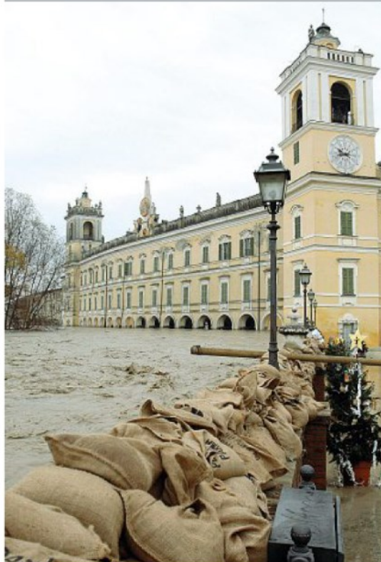
I danni causati dalle esondazioni del torrente Parma a Colorno
