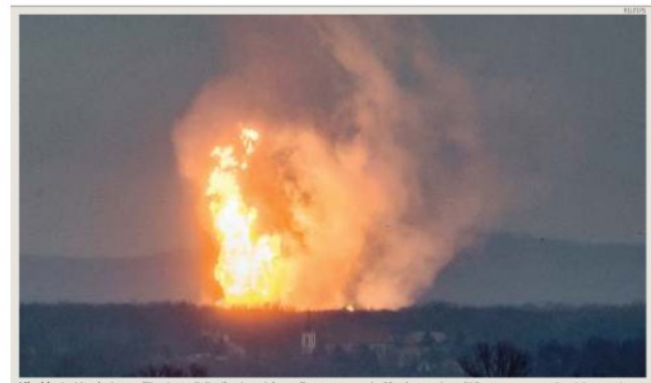
L'incidente. L'esplosione nell'impianto di distribuzione del gas a Baumgarten an der March, a nord-est di Vienna
